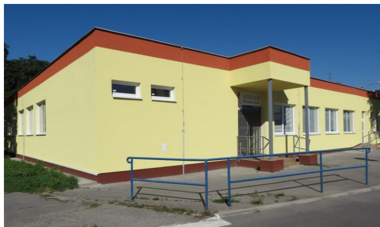
Jedáleň po rekonštrukcii
