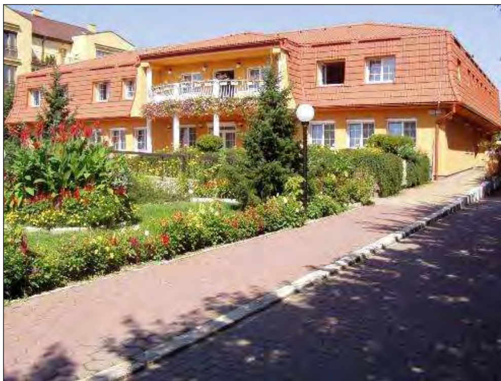
Obr. 22 Budova Spoločensko-relaxačného centra, Milosrdenstva 4
