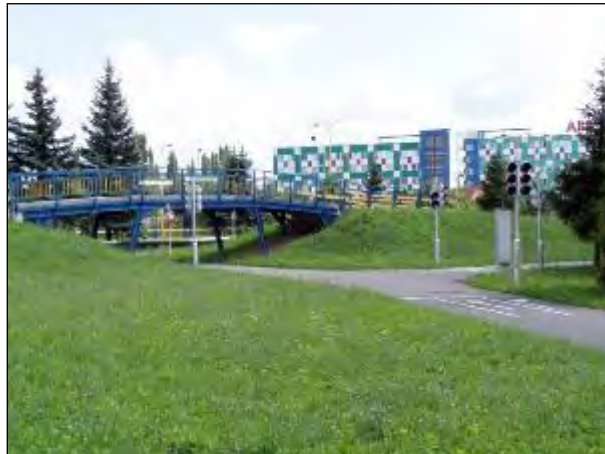
Obr. 33 Dopravné ihrisko ŠZA - nadjazd
