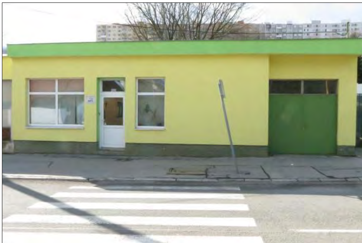
Obr. 3 Budova Miestneho podniku služieb, s.r.o. Košice, Rastislavova 63
