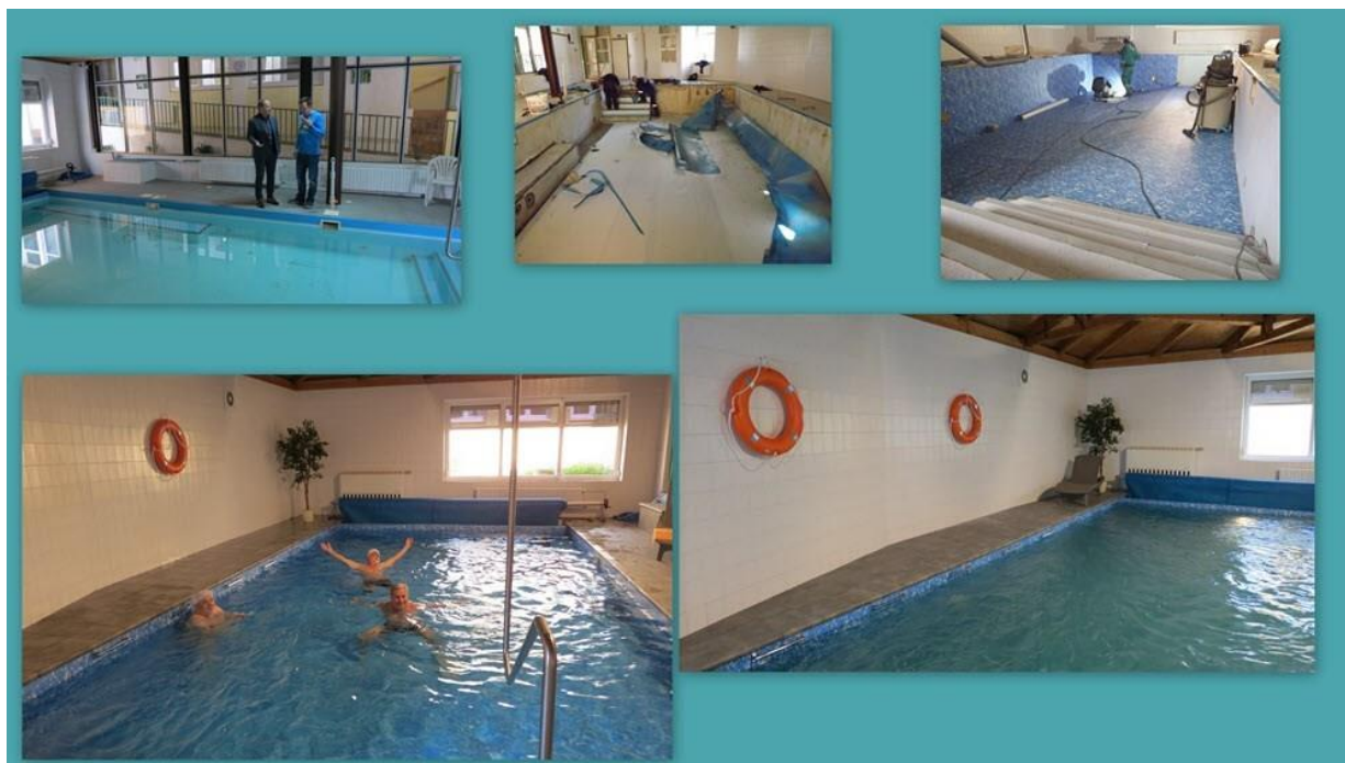
Obr. 42 Rekonštrukcia bazéna v roku 2018
