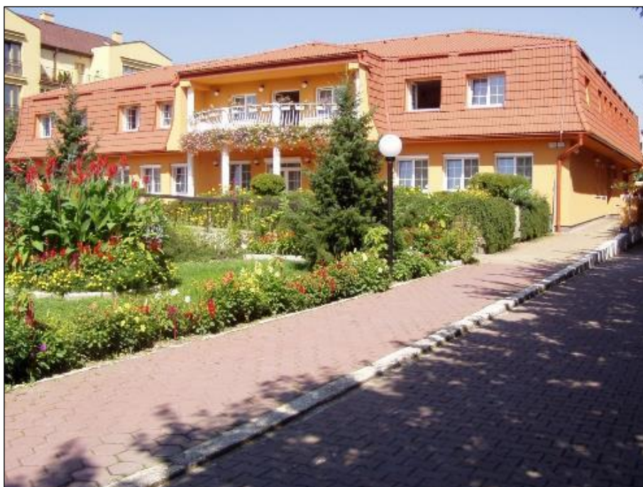
Obr. 38 Budova Spoločensko-relaxačného centra, Milosrdenstva 4
