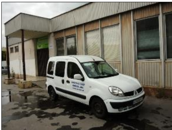
Obr. 22 Jedáleň pre dôchodcov, Vojvodská 5 pôvodný stav
