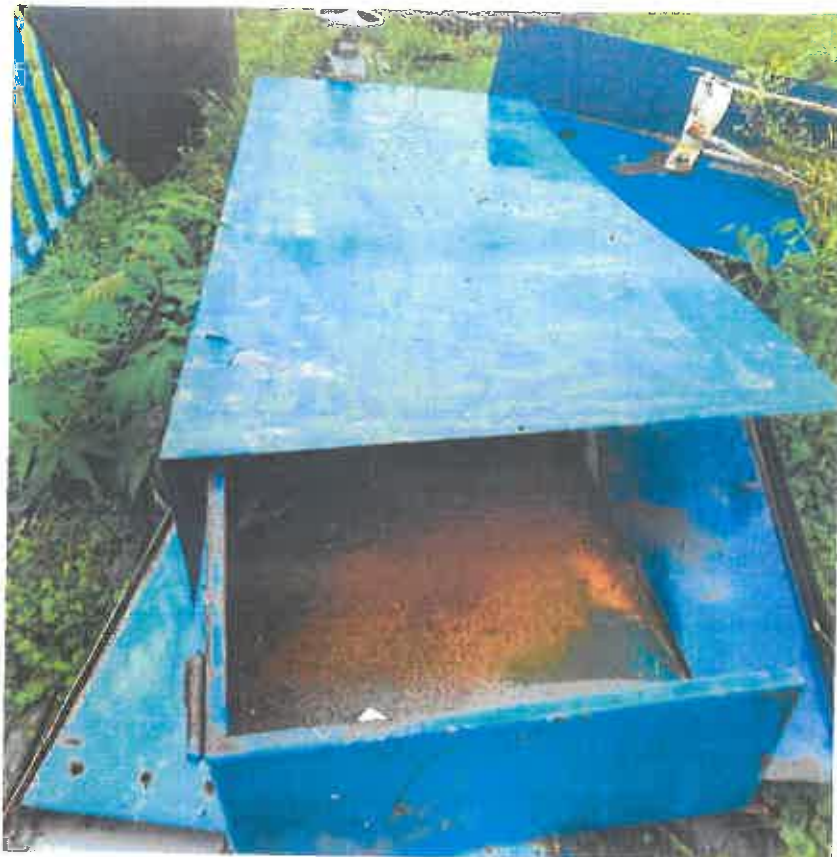
Obr. č. 4 Plechové krytie rozdeľovačov a zberačov
