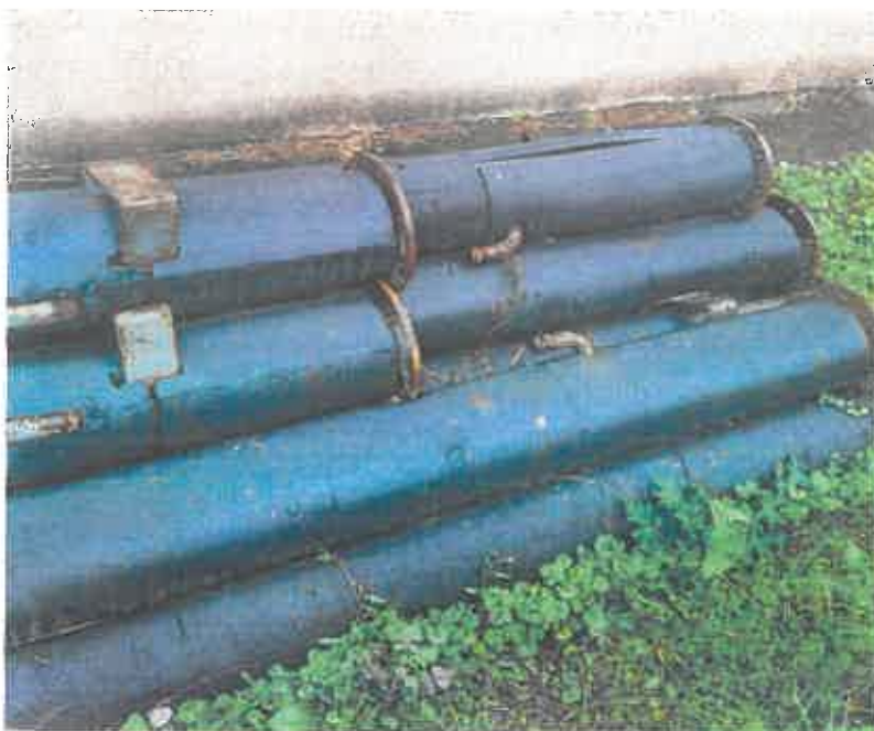
Obr. č. 2 Zberače s namontovanými vývodmi pre rozdeľovače
