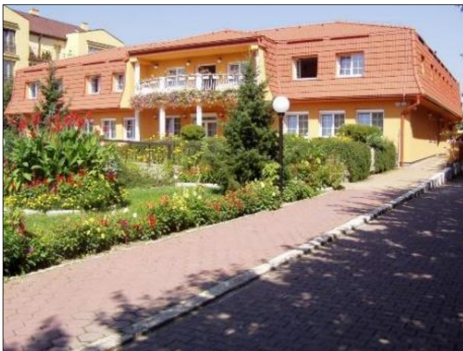
Obr. 41 Budova Spoločensko-relaxačného centra, Milosrdenstva 4
