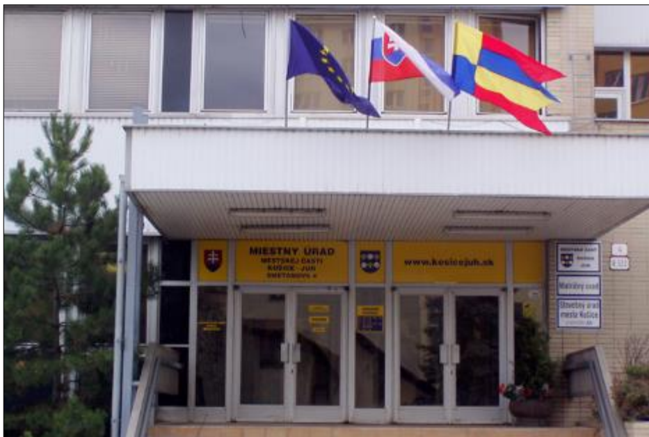
Obr. 13 Vstup do budovy MÚ MČ Košice – Juh, Smetanova 4
