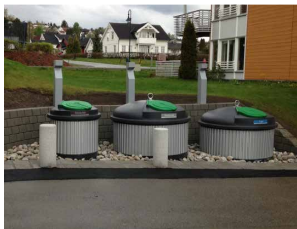
Polopodzemné kontajnery na komunálny a recyklovaný odpad
