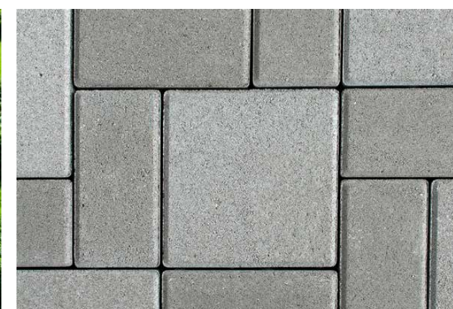
Chodník z betónovej zámkovej dlažby sivej farby
