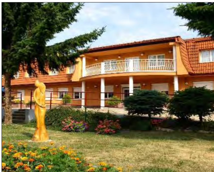
Obr. 39 Budova Spoločensko-relaxačného centra, Milosrdenstva 4
