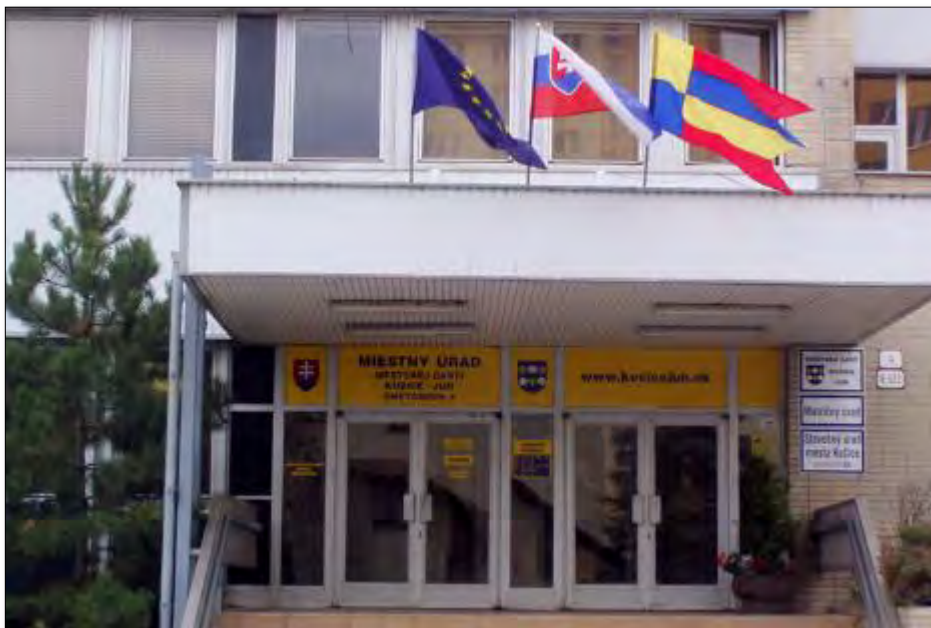
Obr. 10 Vstup do budovy MÚ MČ Košice – Juh, Smetanova 4
