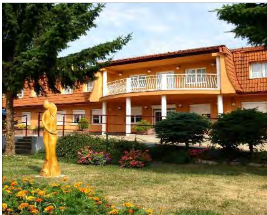
Obr. 43 Budova Spoločensko-relaxačného centra, Milosrdenstva 4
