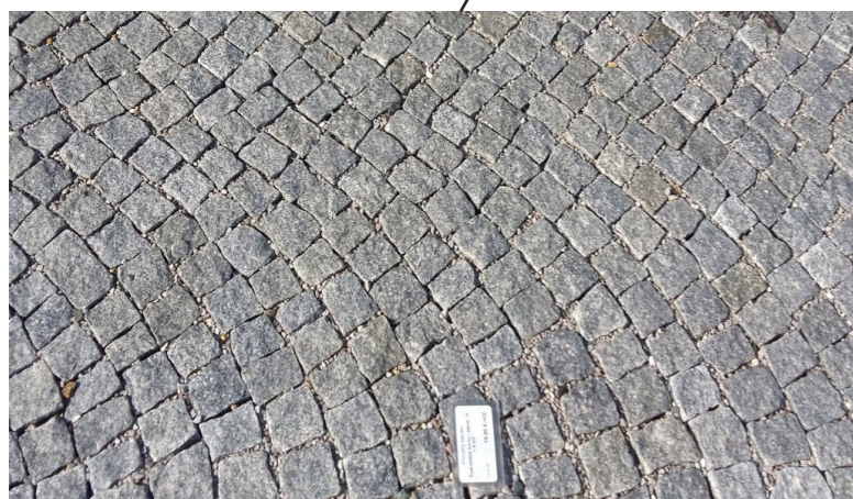
Kamenná dlažba kombinovaná so svetlých žulových kociek
