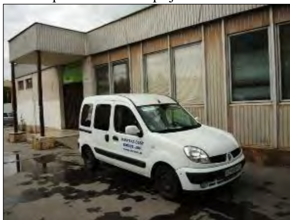
Obr. 34 Jedáleň pre dôchodcov, Vojvodská 5 pôvodný stav
