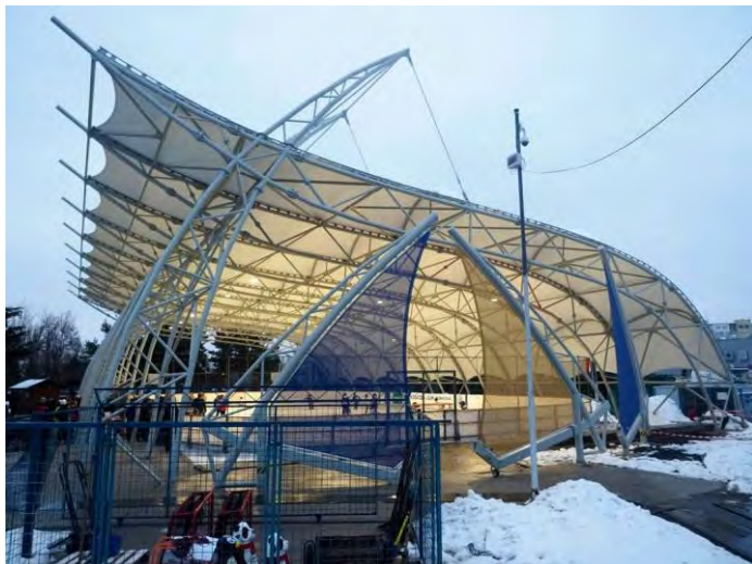
Obr. 15 Prestrešenie ľadovej plochy na ŠZA
