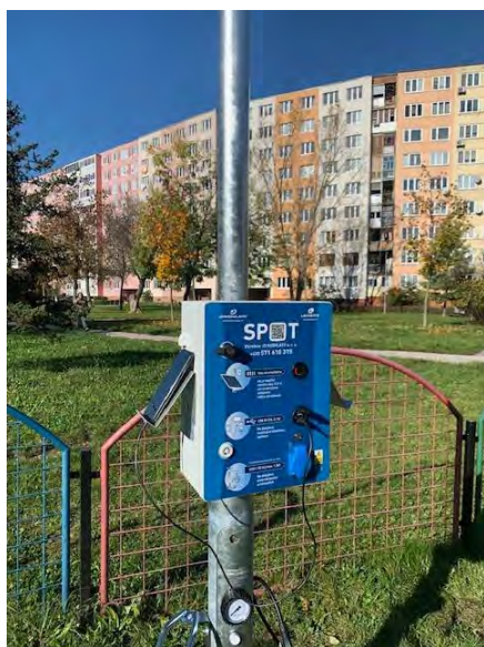
Obr. 9 a 10 Solárne LED osvetlenie s nabíjacou stanicou
