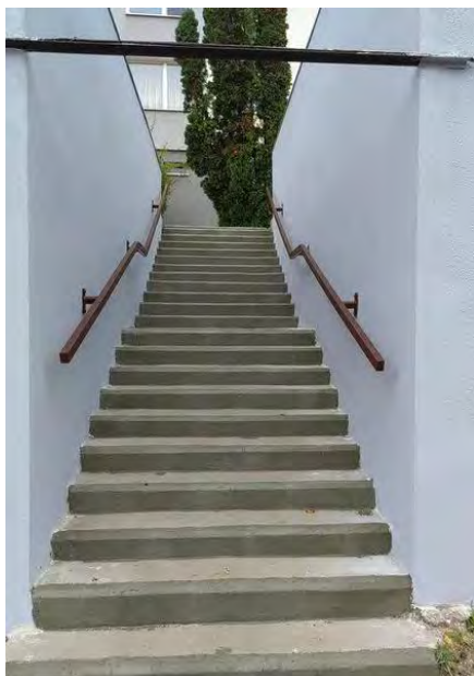
Obr. 11 a 12 Opravené medzigarážové schodiská na Turgenevovej ulici
