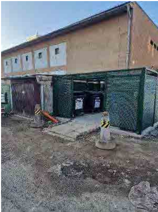
Osadenie zábran zamedzujúcich parkovanie motorových vozidiel pri novo zriadenom kontajnerovisku na Južnej triede 91.
