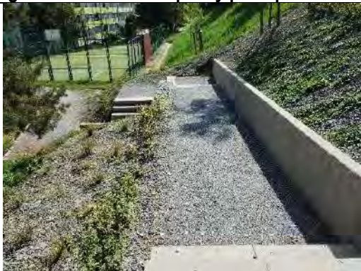
POHĽAD ZDOLA – príchod ku gabionu a prvému schodisku vľavo. Poznámka: iba jeden gabion – podľa projektovej dokumentácie mali byť tri gabiony
