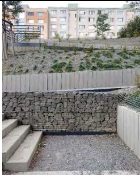
POHĽAD ZDOLA – príchod ku gabionu a prvému schodisku vľavo. Poznámka: iba jeden gabion – podľa projektovej dokumentácie mali byť tri gabiony
